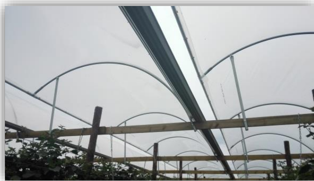
Figuur 30. – Opvang van hemelwater via goten tussen de regenkapten.
